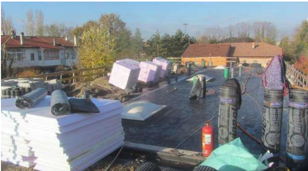
lavori in corso
